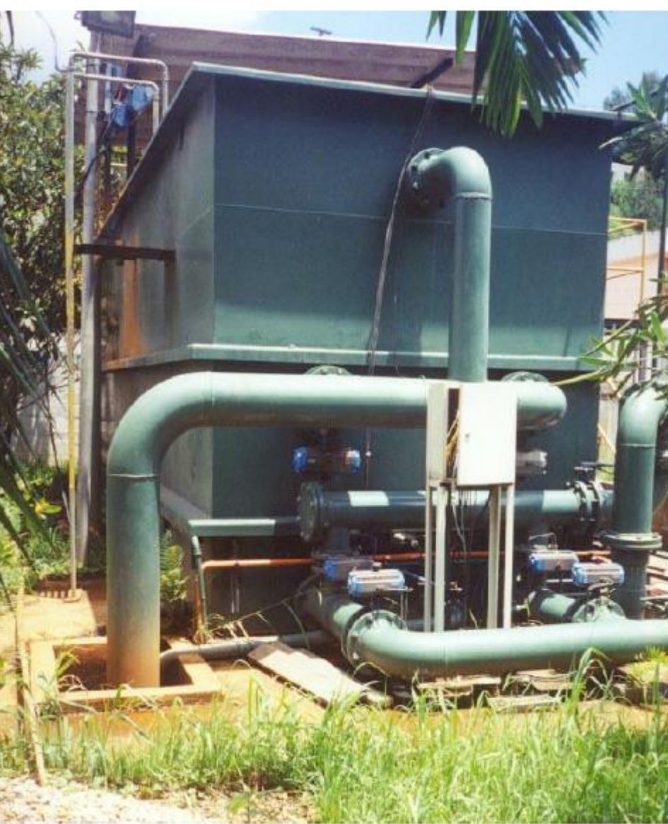
Unidade de flotação da ETA Mairiporã da Sabesp
