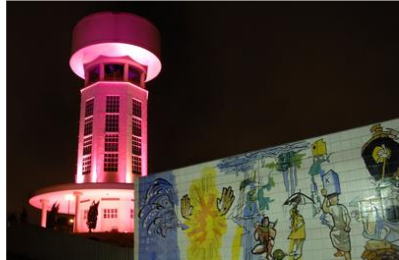
Reservatório de água Alto da XV, em Curitiba
